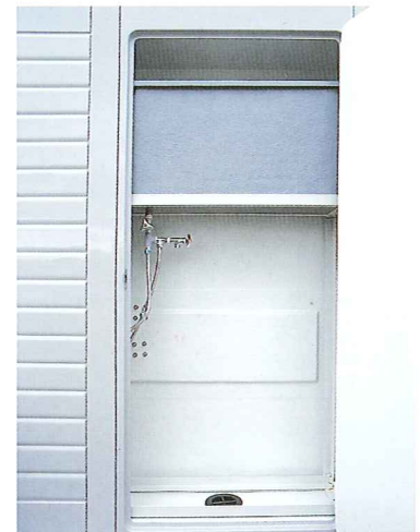
簡易水洗用水タンク及び汲取口
